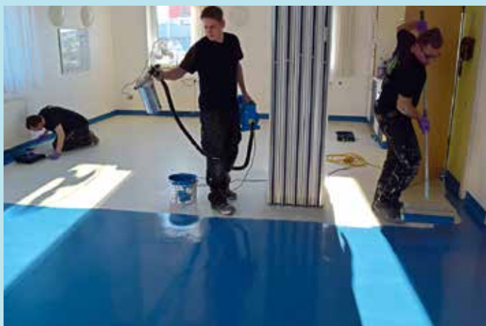
Der Boden ist anschließend neutralisiert und getrocknet worden. Im Bild: Links werden die Ränder vorbereitet, rechts wird die farbige Versiegelung aufgetragen und darauf werden kleine Chips geblasen (Mitte).
