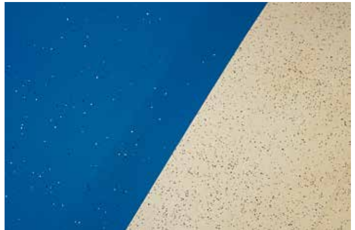
Vergleich im Detail: Links der neue Bodenbelag, rechts der alte, allerdings bereits geschliffen und gereinigt.
